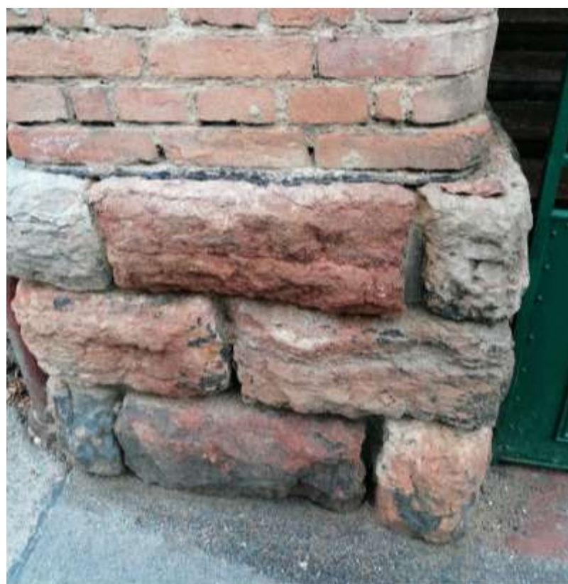
Obr. 2: Původní vodorovná asfaltová hydroizolace nad kamenným soklem
