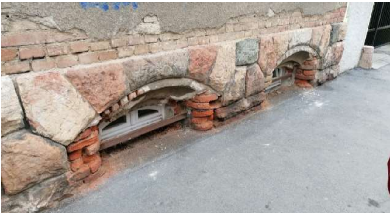
Obr. 4: Degradační procesy cihelného zdiva vyvolané synergií odstříkující vody na terénu a na horní hraně předsazeného soklu a rozpustnými solemi
