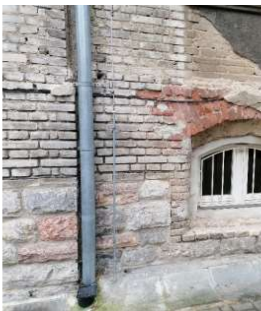
Obr. 5: Opadaná omítka v místě dříve nefunkčního dešťového svodu
